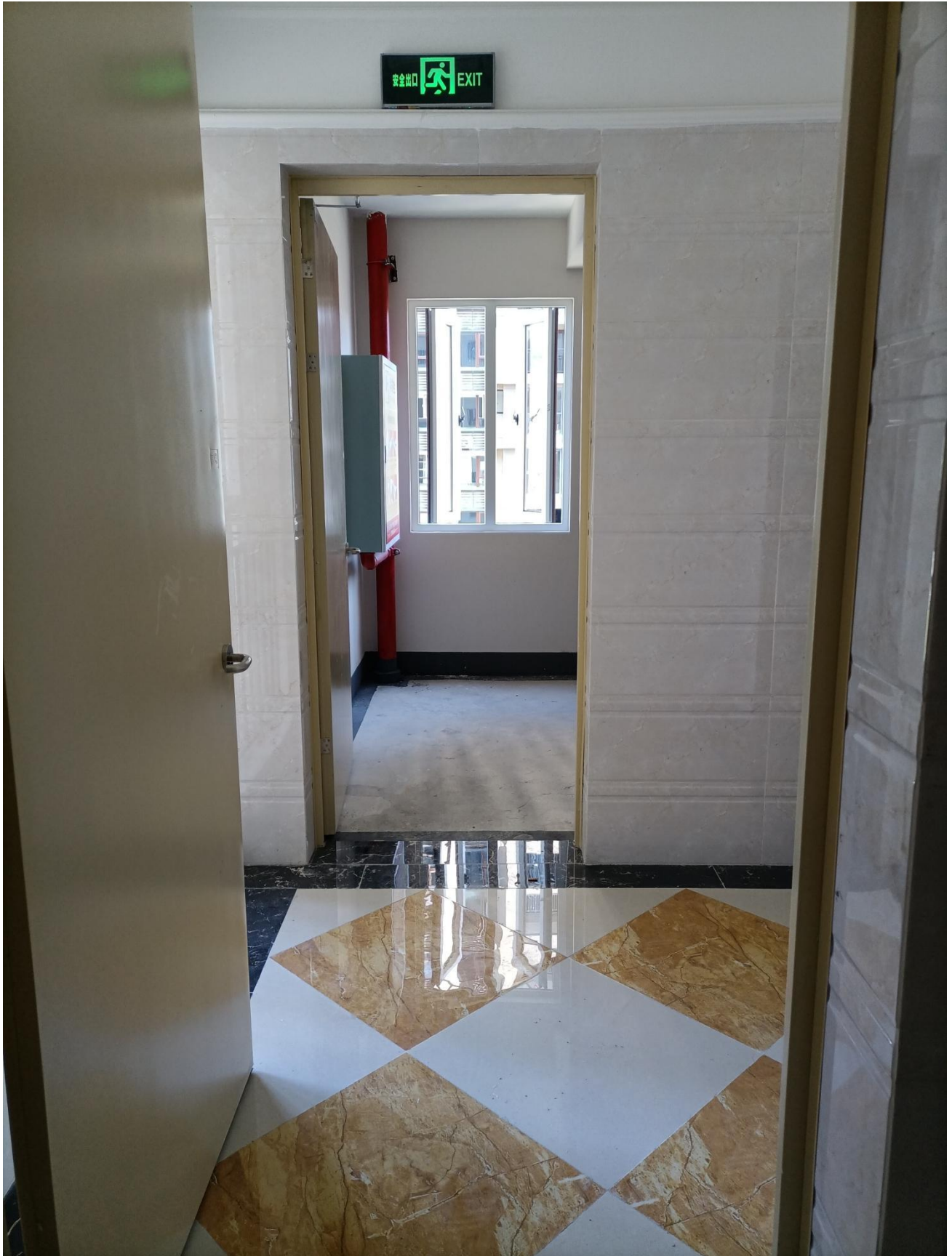
电梯及楼梯间
